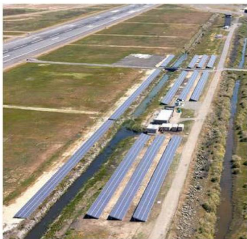
Esempi di impianti fotovoltaici in ambito aeroportuale. La disposizione dei moduli fotovoltaici in prossimità delle piste di atterraggio/decollo non rappresenta un rischio per la sicurezza
