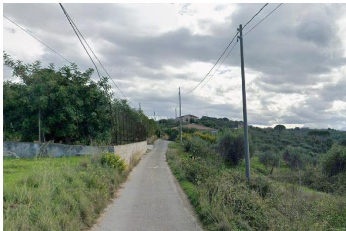
Area oggetto d'intervento – Tratto di strada
